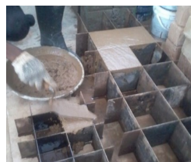
(d) Cube casting process
